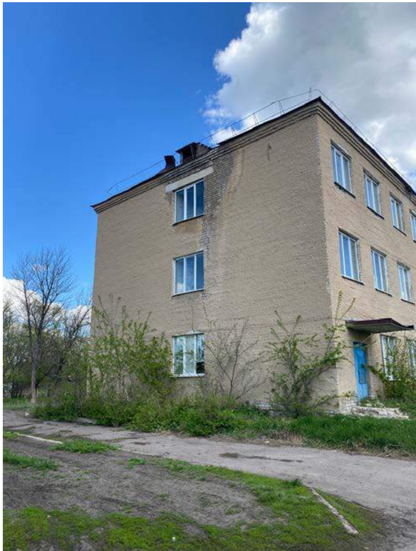
Больница (в аварийном состоянии, закрыта)
